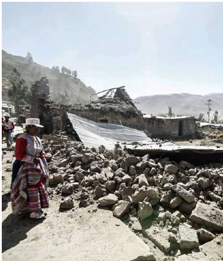
Vivienda destruida por el sismo del 2016
